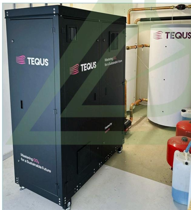
Самый мощный тепловой насос развивает тепловую мощность 268 кВт, холодопроизводительность – 267 кВт. Значения COP нагрева и охлаждения находятся на уровне 5,4 и 4,5 соответственно. Самый маленький в линейке насос обеспечивает мощность обогрева 18 кВт, охлаждения – 17 кВт. КПД для отопления составляет 5,0, а для охлаждения – 4,4.
