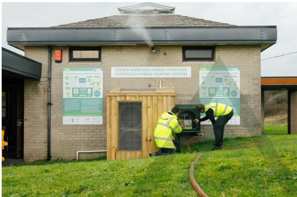
**В западном Уэльсе испытывается гибридная система, сочетающая тепловой насос с воздушным источником, водородный котел и интеллектуальное управление, чтобы изучить потенциал новой технологии для низкоуглеродного теплоснабжения.**
